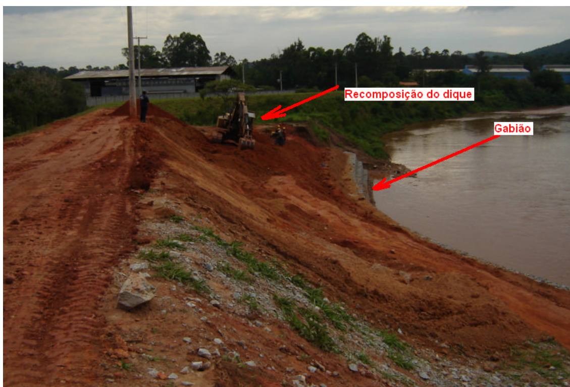
FIGURA 2 – Atividades de recuperação da margem esquerda do rio das velhas em curva crítica (23/11/06).
